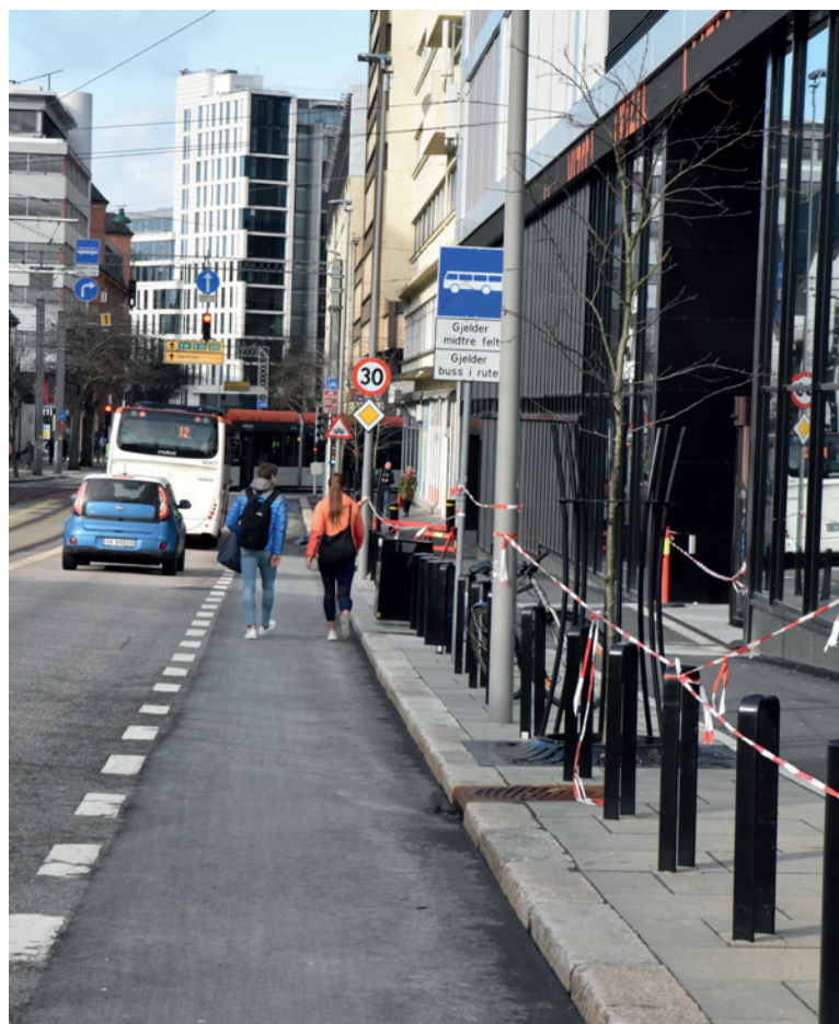
Midlertidig stenging av fortau, der informasjon mangler og fotgjengerne utsettes for trafikkfare
